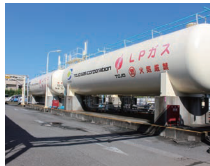
首都圏統轄支店（埼玉県富士見市）
